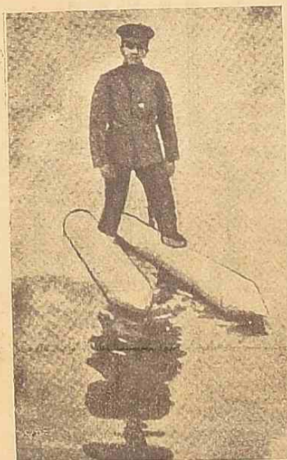
„Моронія галоши“ Ученикъ обш. консерваторіи М. Еглом-Бергъ изобрѣлъ водянныя лыжи, отличающіяся необыкновенной легкостью и быстротою хода, достигающей 15 верстъ въ часъ.
