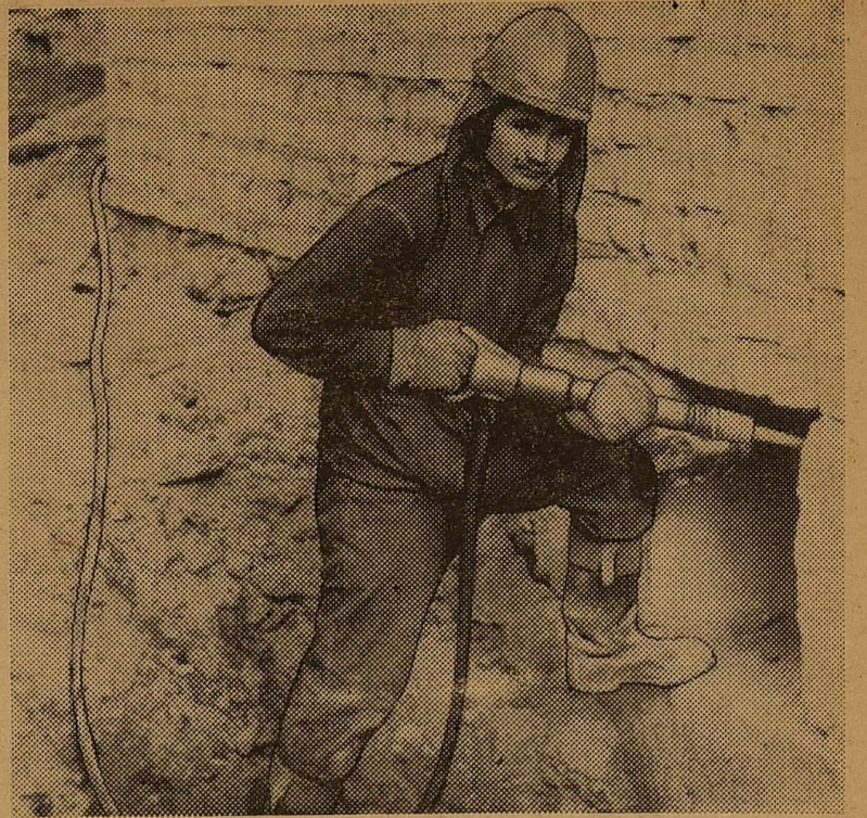
На будівництві гуртожитку № 1 відмінно працює студент ІV курсу істфаку Олександр Миндру, якого ви бачите на знімку.
