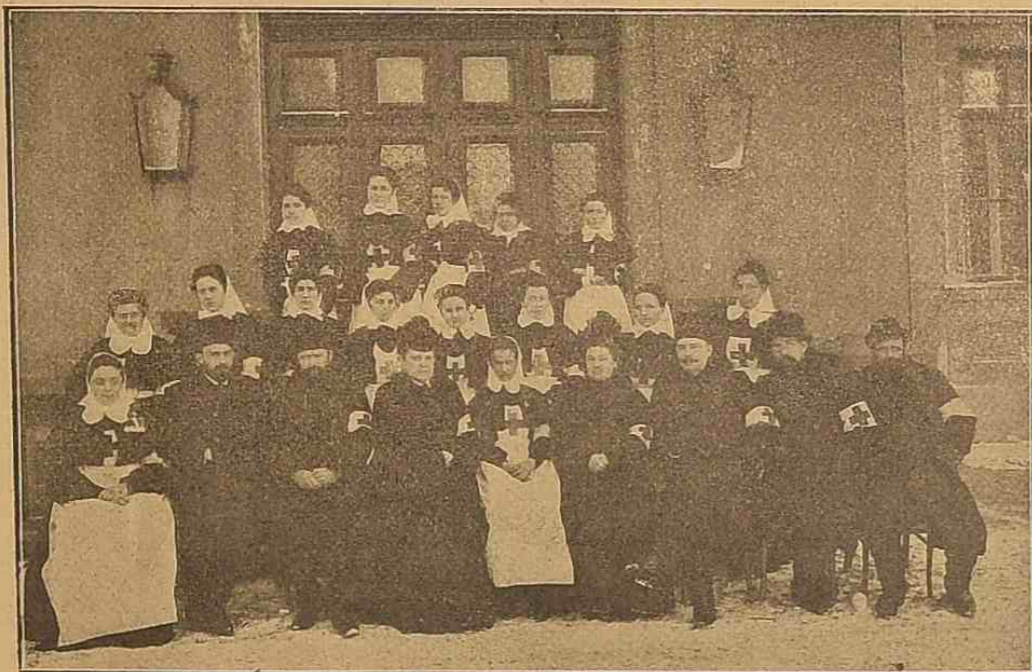
Первый санитарный отрядъ Касперовской общины „Краснаго Креста“. Съ фот. Вл. Эрманса.
