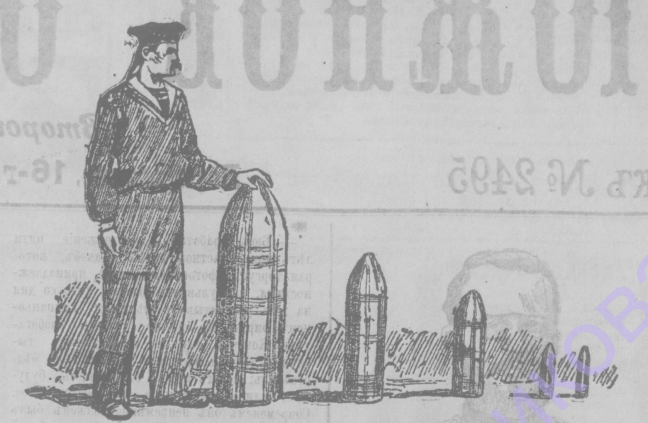
Сравнительные размеры японскихъ снарядовъ, выпущенныхъ въ время бомбардировки Порт-Артурса: 1) 12-дюймовый снарядъ; 2) 6-дюймовый броненосный снарядъ; 3) 8-дюймовый снарядъ; 4) 47 мм. снарядъ; 5) снарядъ скорострѣлки Гокина.
