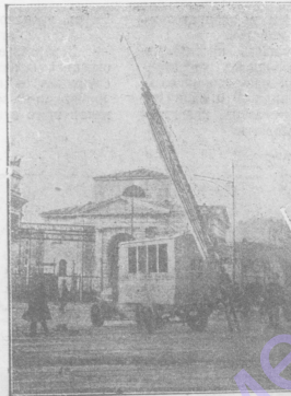
Установка отправительнаго аппарата.
