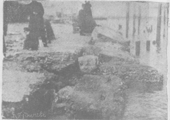
Различные бурей массивы послѣдней укладки предназначены для многояктыго сопротивленія напорамъ волнъ.
