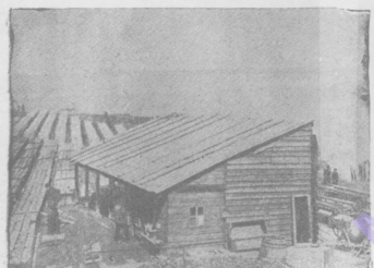
Заготовка масивовъ для укрѣпленія берега Ланжерона.
