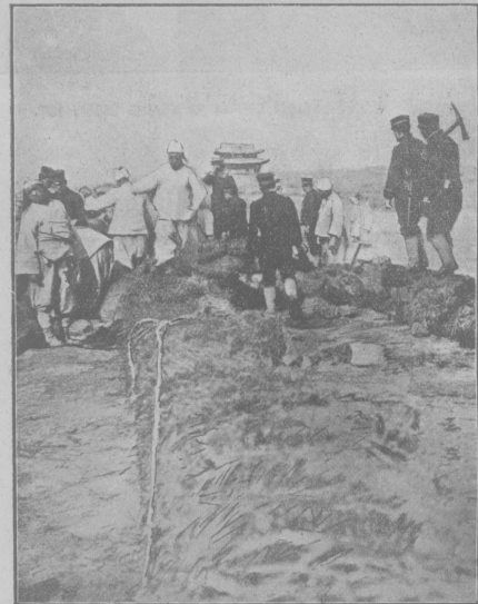
Сооруженіе японцами моста черезъ р. Тайтонгъ у Пиньяна.
