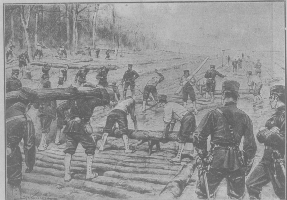
Сооруженіе дорогъ по непроходимымъ мѣстамъ Кореи японскими инженерными командами.
