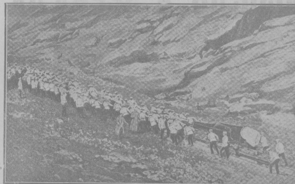
Въ Портъ-Артурѣ.—Подъемъ большого орудія на батарею.
