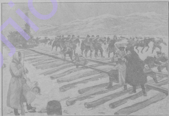
Постройка желѣзной дороги по льду Байкальскаго озера.
