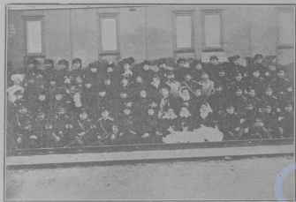
Предъ отъезде 55-го Сибирского военно-синаггского полка из Одессы на Д. Восток
