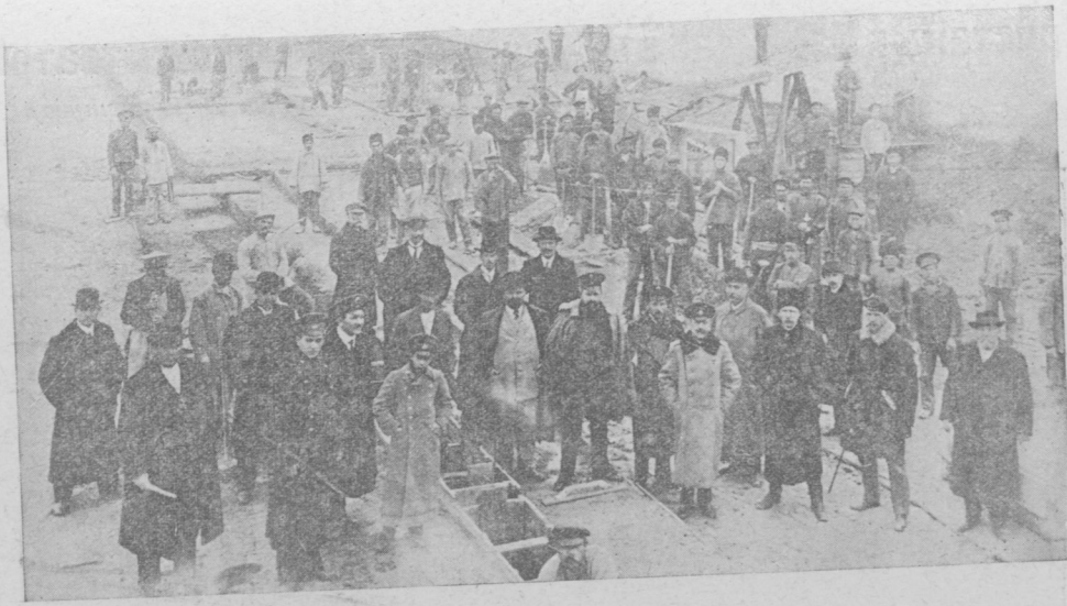
ОДЕССА.—Осмотръ комиссіей изъ гласныхъ и гор. служащихъ фильтра № 11 на водопроводной станціи „Днѣстръ“ въ селеніи Бѣляевкѣ. (Фот. Я. А. Бялоцерковскаго).
