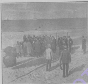
Прокладка нового транспортно-технического шоссе.
