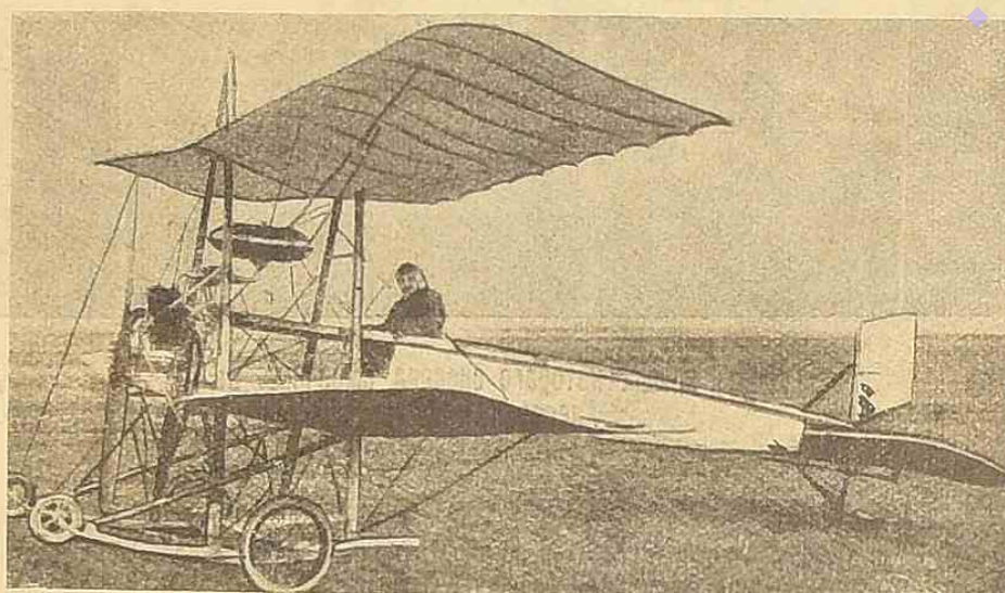
Первый русскій аэропланъ инж. Я. М. Гаккеля.
