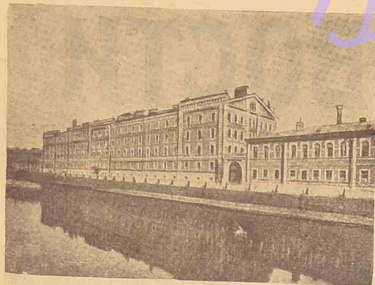
Фасадъ казармъ Гвардейскаго экипажа со стороны Екатерининск. канала.
