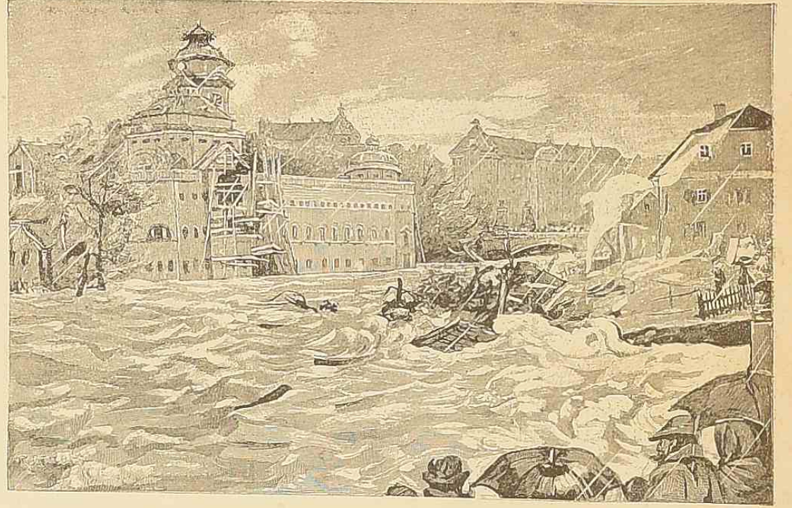
Разрушенные дома и постройки.
