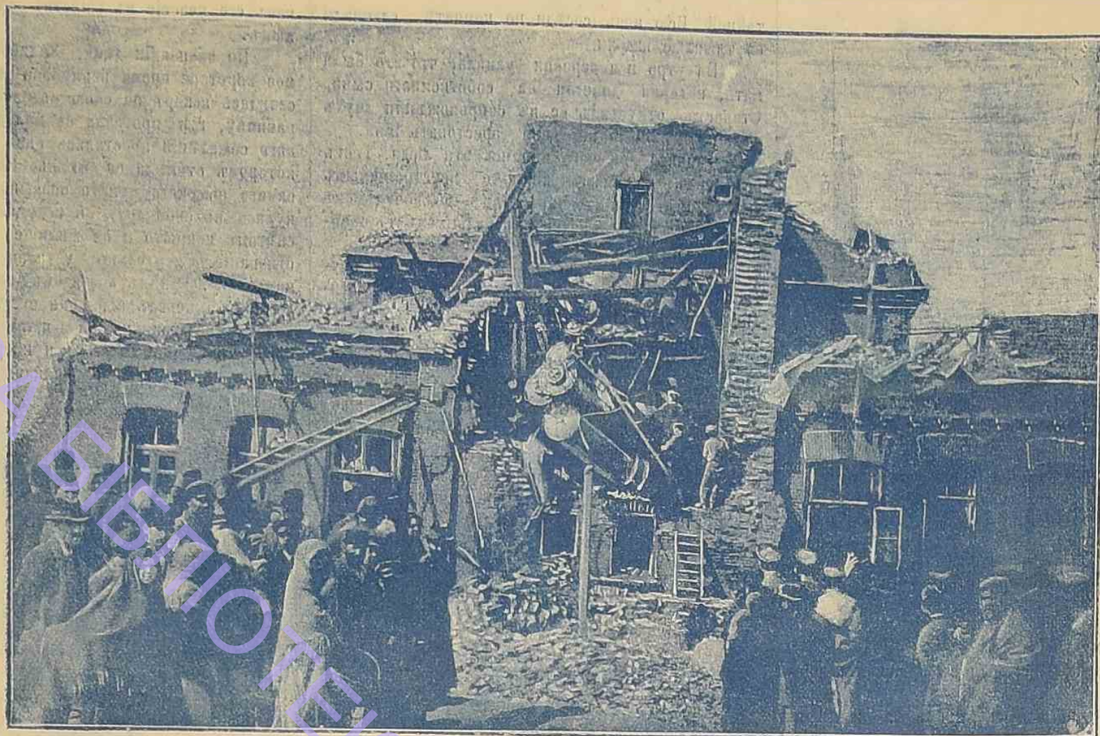
АККЕРМАНЪ.—Казенный очистной складъ № 9, разрушенный взрывомъ 30 марта. (Съ фотогр. Г. Гулевича).
